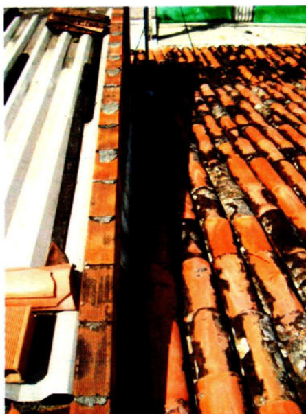
Foto 09 – Detalhe das paredes divisórias dos imóveis
