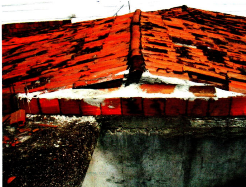
Foto 08 – Detalhe do telhado do Imóvel do autor
