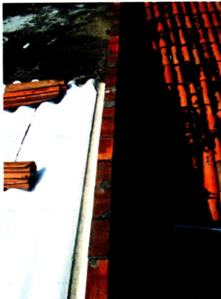
Foto 06 – Detalhe das paredes divisórias dos imóveis
