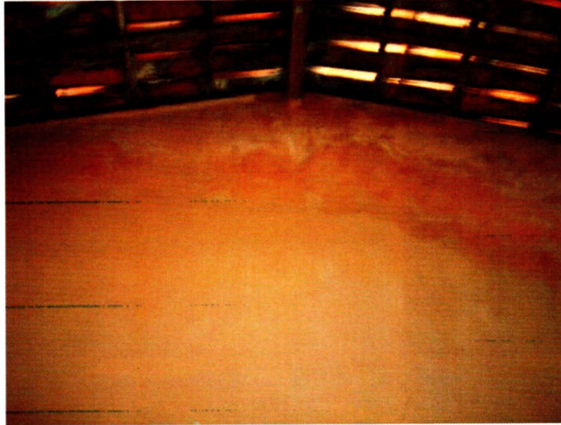
Foto 04 – Detalhe de parede com “umidade excessiva”, no Imóvel do autor
