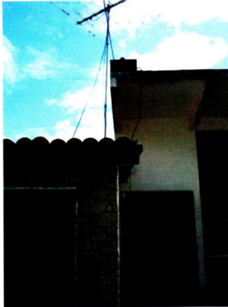
Foto 02 – Detalhe da Fachada dos imóveis periciados
