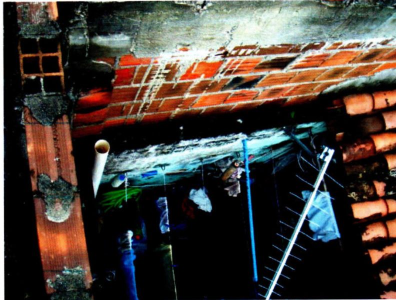
Foto 10 – Detalhe das paredes divisórias dos imóveis
