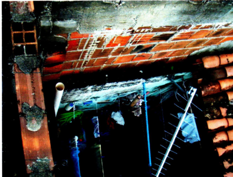
Foto 10 – Detalhe das paredes divisórias dos imóveis
