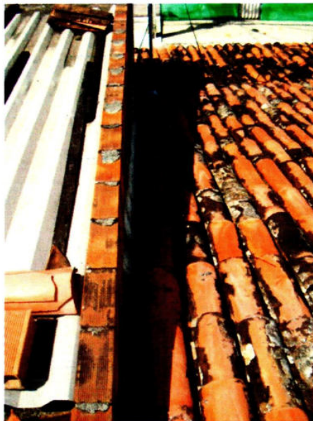
Foto 09 – Detalhe das paredes divisórias dos imóveis
