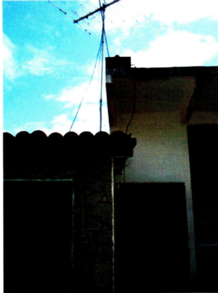
Foto 02 – Detalhe da Fachada dos imóveis periciados
