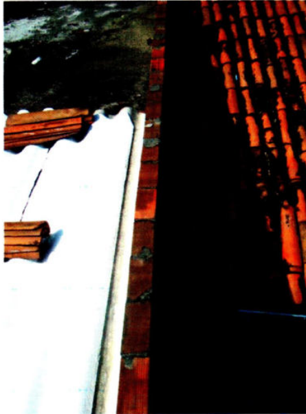
Foto 06 – Detalhe das paredes divisórias dos imóveis
