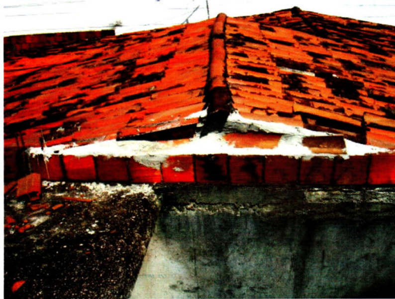
Foto 08 – Detalhe do telhado do Imóvel do autor
