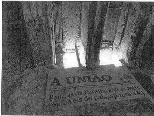
Foto 43 – à esquerda, a vigota da laje e, à direita, blocos cerâmicos.
