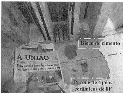
Foto 39 – Orifícios indicam ponto de transição do muro de divisa em alvenaria de tijolo e o coroamento executado em bloco de cimento.
