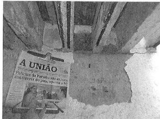
Foto 38 – A amostragem revela duas camadas de emboço: uma contendo barro (cor característica) e a segunda, mais recente, pintada na cor branca.
