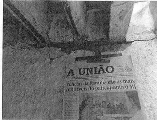
Foto 36 – A imagem e a Foto 35 ao lado expõem a fissuração horizontal na base das peças de pέργula.
