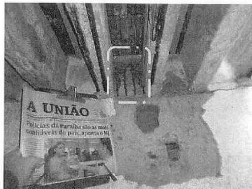
Foto 40 – Mesma foto anterior: indicação de tijolo cerâmico no abafamento das peças da pέργula. Tijolos assentados com furos na vertical com massa.
