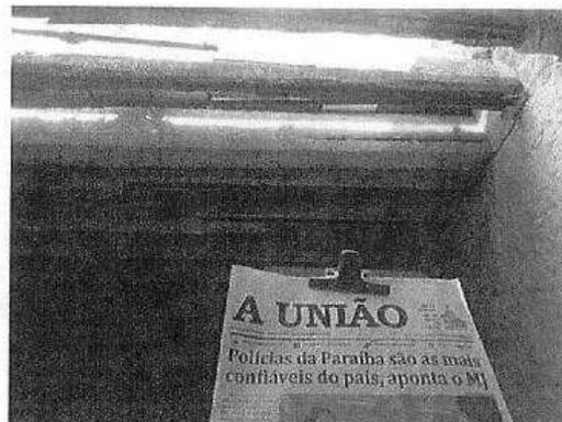
Foto 32 – Trecho mostra que parte do concreto de recobrimento do aço já havia desmoronado. Risco iminente de acidentes com danos a pessoas e bens materiais.
