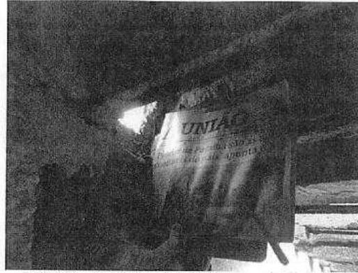
Foto 42 – Aproximação da imagem da Foto 41, dando noção da pouca profundidade de apoio dos componentes da laje acrescida.
