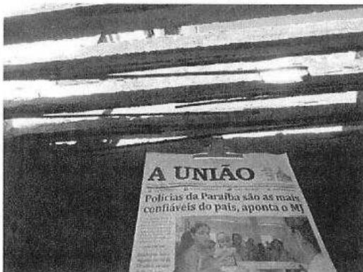
Foto 27 – Pérgula com ferragens exposta, oxidada e em vários pontos rompida.
